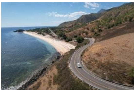
完成した国道1号整備事業（ディリ～バウカウ）
